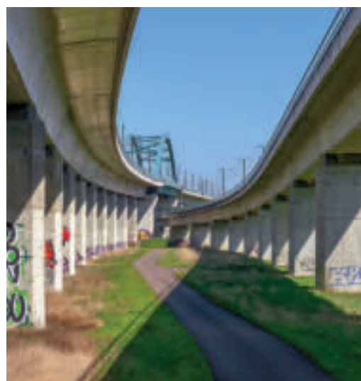
Brücken in Sachsen-Anhalt: Saale-Elster-Talbrücke (Saalekreis). Titelbild: Fredi Fröschki
