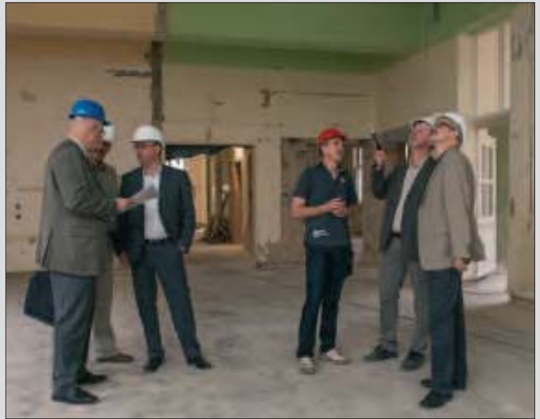
Besichtigung der Baustelle der Zahnklinik im Sommer 2015. Nach einer Klage verzögerten sich die Bauarbeiten. Foto: Archiv
