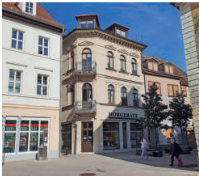
Die Praxis von Bettina Wenzel liegt im Herzen von Weißenfels direkt am Markt in der 2. Etage sowie im Dachgeschoss eines sanierten Altbaus. Die Praxis ist über einen Fahrstuhl erreichbar.
