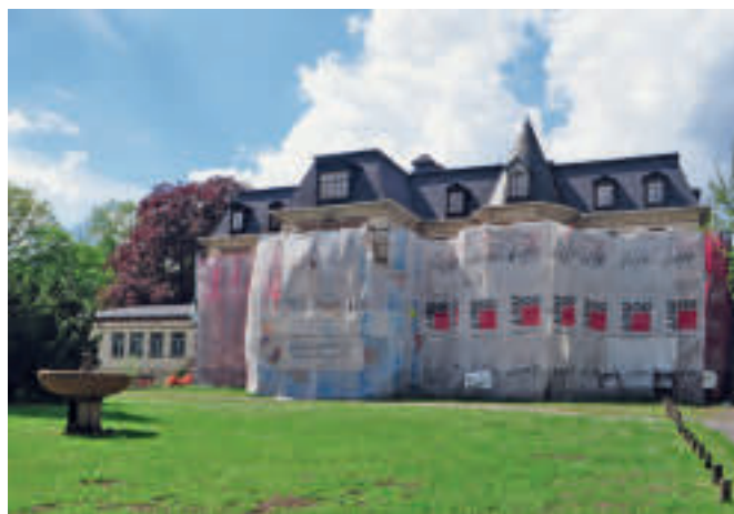
Die 1873/74 gebaute „Alte Villa“ wurde nach der deutschen Einheit mehrfach verkauft. Derzeit gehört sie Investoren aus Bulgarien. Die Sanierung geht seit Jahren nicht voran.
