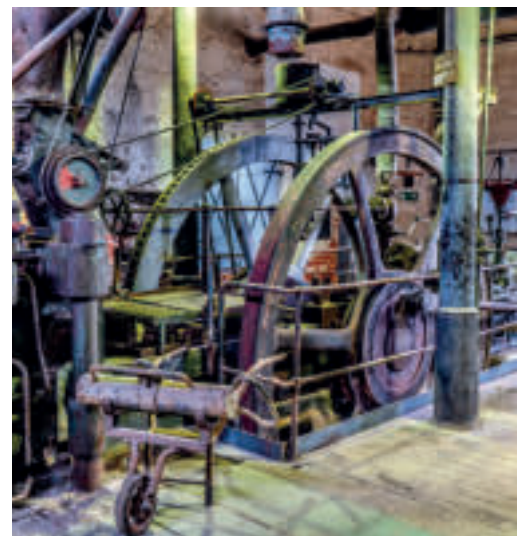
Brikettfabrik Hermannschacht in Zeitz.
